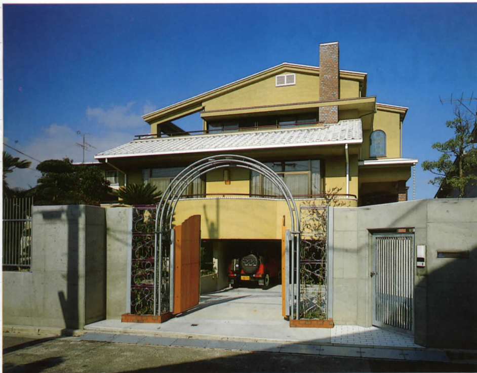
② 建物は半地下室（ガレージほか）のある3層になった堂々とした外観
