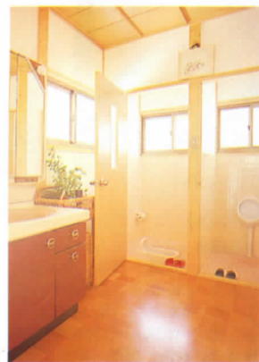
床暖房の洗面所と便所 床・寄木合板、タイル
