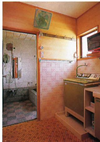
床暖房で快適な洗面・ 脱衣所と浴室 床・長尺塩ビシート タイル
