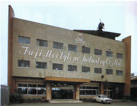
②外観。1階の事務室に床暖房が導入されています
