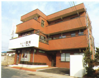
②遠藤邸は鉄筋コンクリート造の3階建てで、1階が美容室「サロン・ド・ミキ」と一部貸し室、2階が住居部分、3階がマンションです
