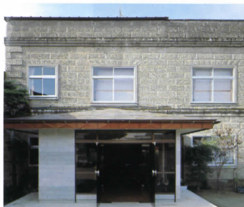
②石貼りの重厚な外観。式場、廊下、便所の床暖房のほか、宿泊室の浴室、建物内の自宅の台所、浴室、洗面所の給湯も1台のボイラーで行われています
