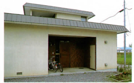
①外観。真ん中のアルコーブの正面が玄関、というつくりです
