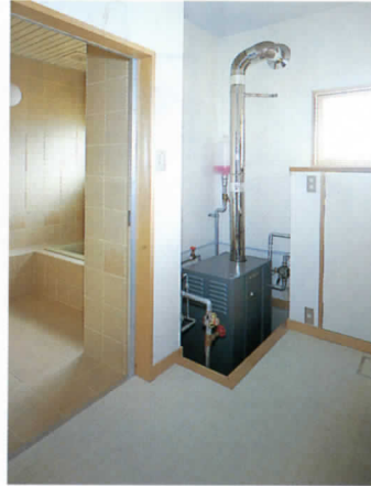
⑤床暖房で快適になった浴室と脱衣室の角に設置されたボイラー 床・タイル、長尺塩ビシート
