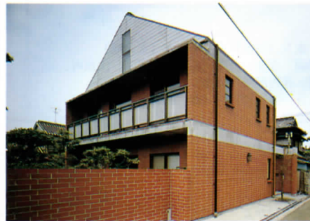
外観。空洞レンガブロックの2階建てに木造屋根をかけています
