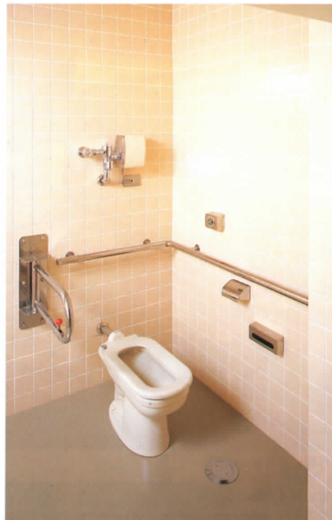
⑨ 便所にはセンサー（壁付き）が取り付けられ、人が通ると感知して自動的に水が流れます
