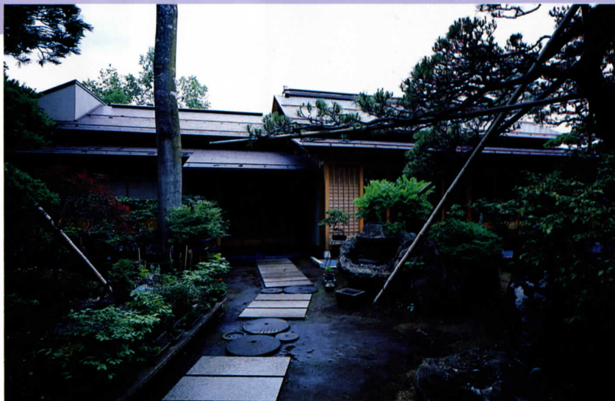
②数寄屋造りの外観。「このあたりは入母屋のガッチリした建物が多いので、少し趣きを変えて数寄屋にしました」と坂本さん
