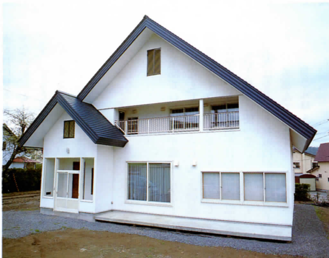
⑤急勾配の大屋根をかけて自然落雪を計画した外観
