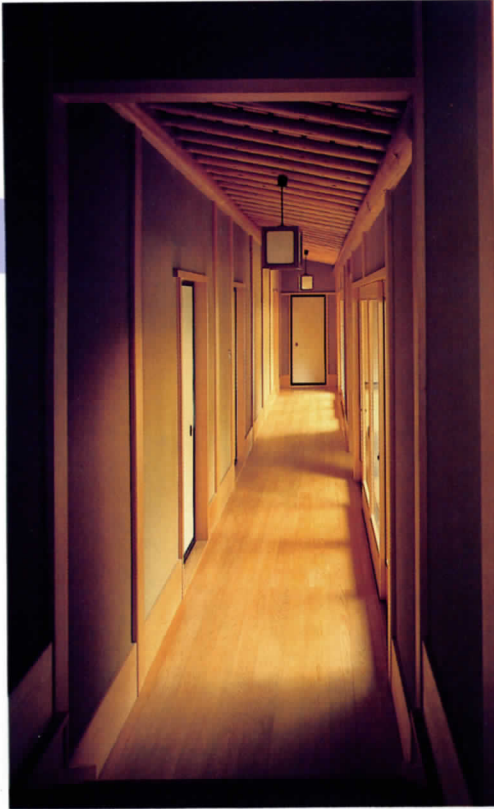
⑤天井の丸太がいかにも「昔の家」という印象を与える、長い廊下 床・ヒノキ縁甲板
