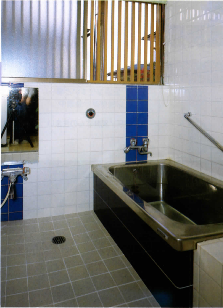
⑤健康への配慮から、浴室の床にも暖房を入れ足からくる冷え込みを解消 床・タイル
