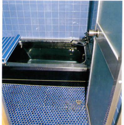
③床暖房の浴室。奥さんが入りやすいよう浴槽を埋め込んでいます 床・タイル
