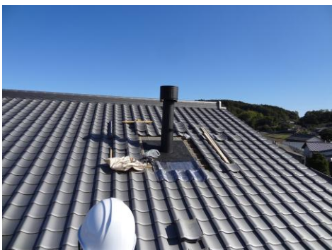
暖炉【フレームアート】の煙突工事 スナップ写真
