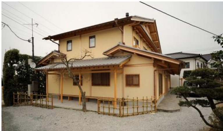
棟木越しに暖炉の煙突が見える
