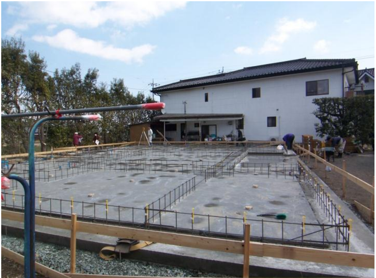
基礎工事、床暖房・暖炉用の配管用スリーブ入れ 2011/03/08
