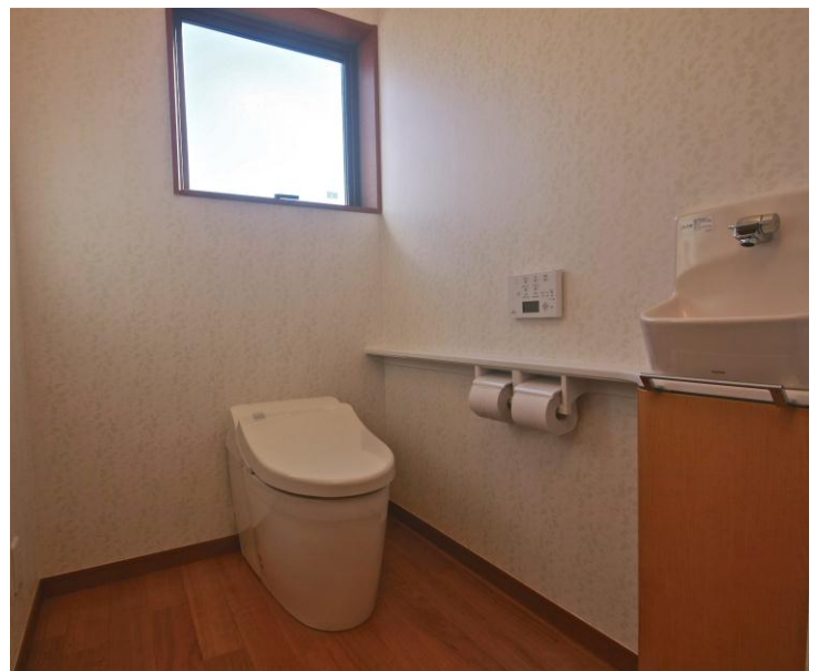
1F トイレも床暖房完備
