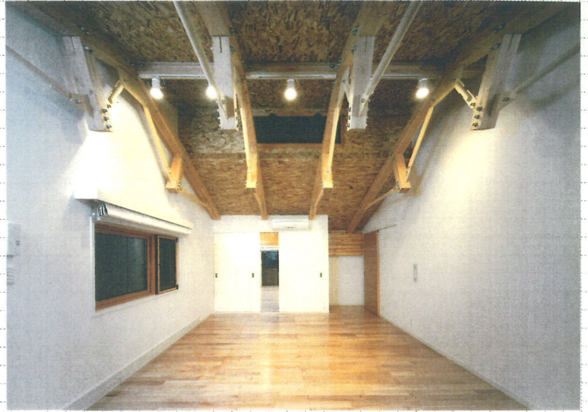
16 BR-4（西側）正面はクロビッド 高天井部に排煙管。
