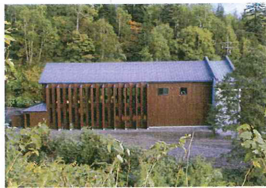
外観：改修後の外壁面に見えるリブは、内部浴場の吹抜けの構造補強であり、デザイン要素である。
